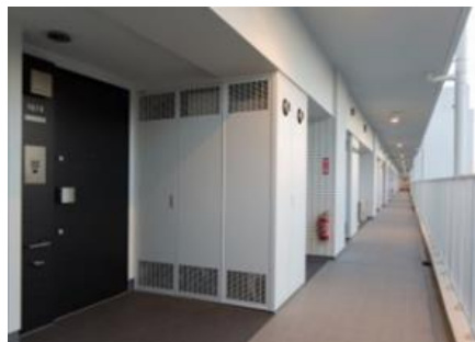
写真2 エネファーム外観
