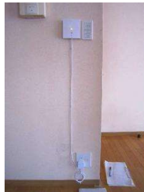
住環境マルチセンサ 設置状況（FL+1,200mm）
