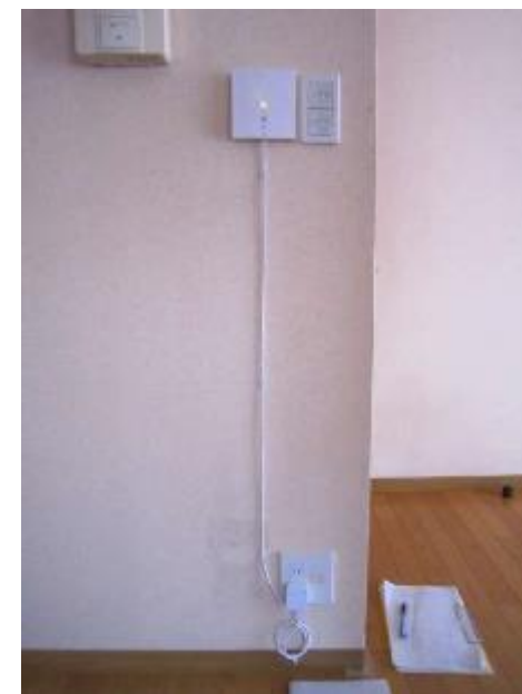
住環境マルチセンサ 設置状況（FL+1,200mm）
