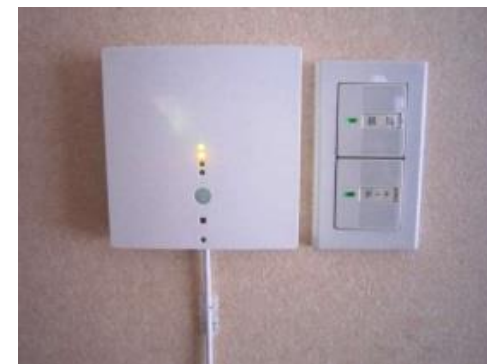
住環境マルチセンサ実証試験器外観
