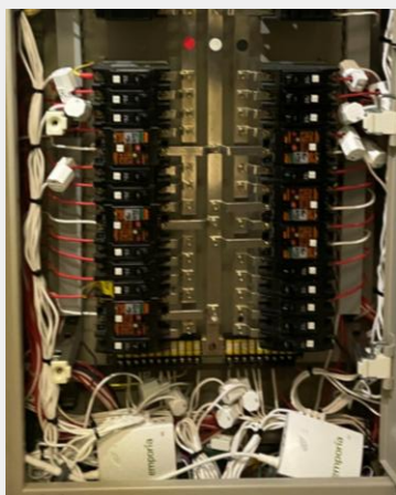
電力センサー設置状態
